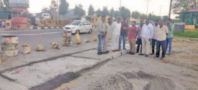
అందర్ గ్రౌండ్ డైనేజీ నిర్మాణ పనులను పరిశీలిస్తున్న దృశ్యం
